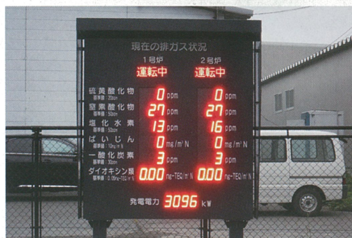
排ガスデータ表示盤
